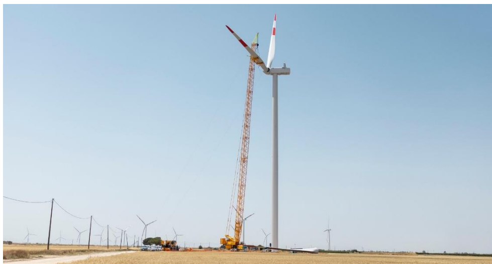
Montage de pales dans le parc éolien de Cerignola en Italie © BKW
