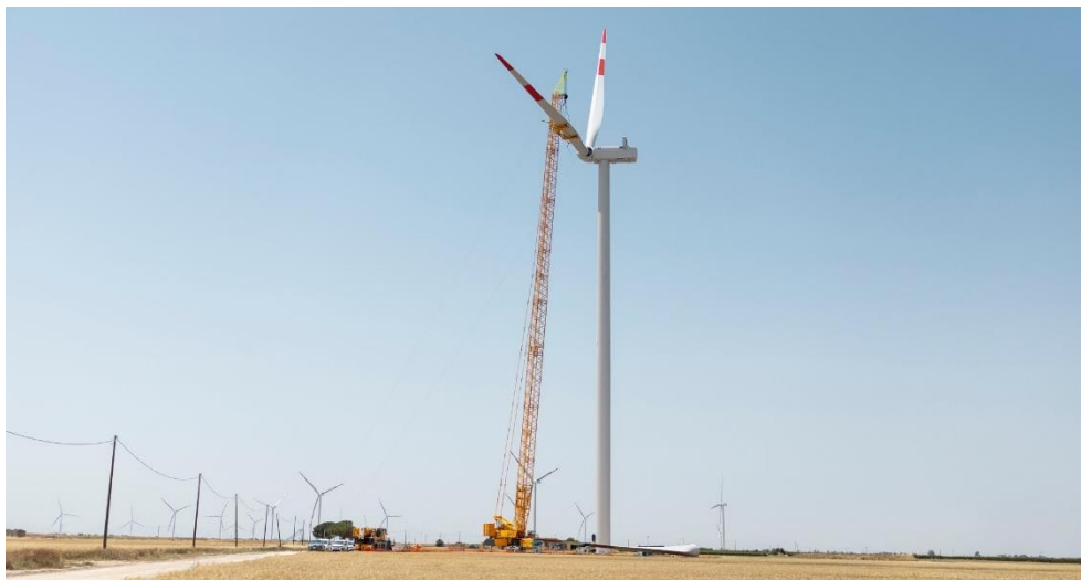
Montaggio delle pale di rotori nel parco eolico di Cerignola in Italia © BKW
